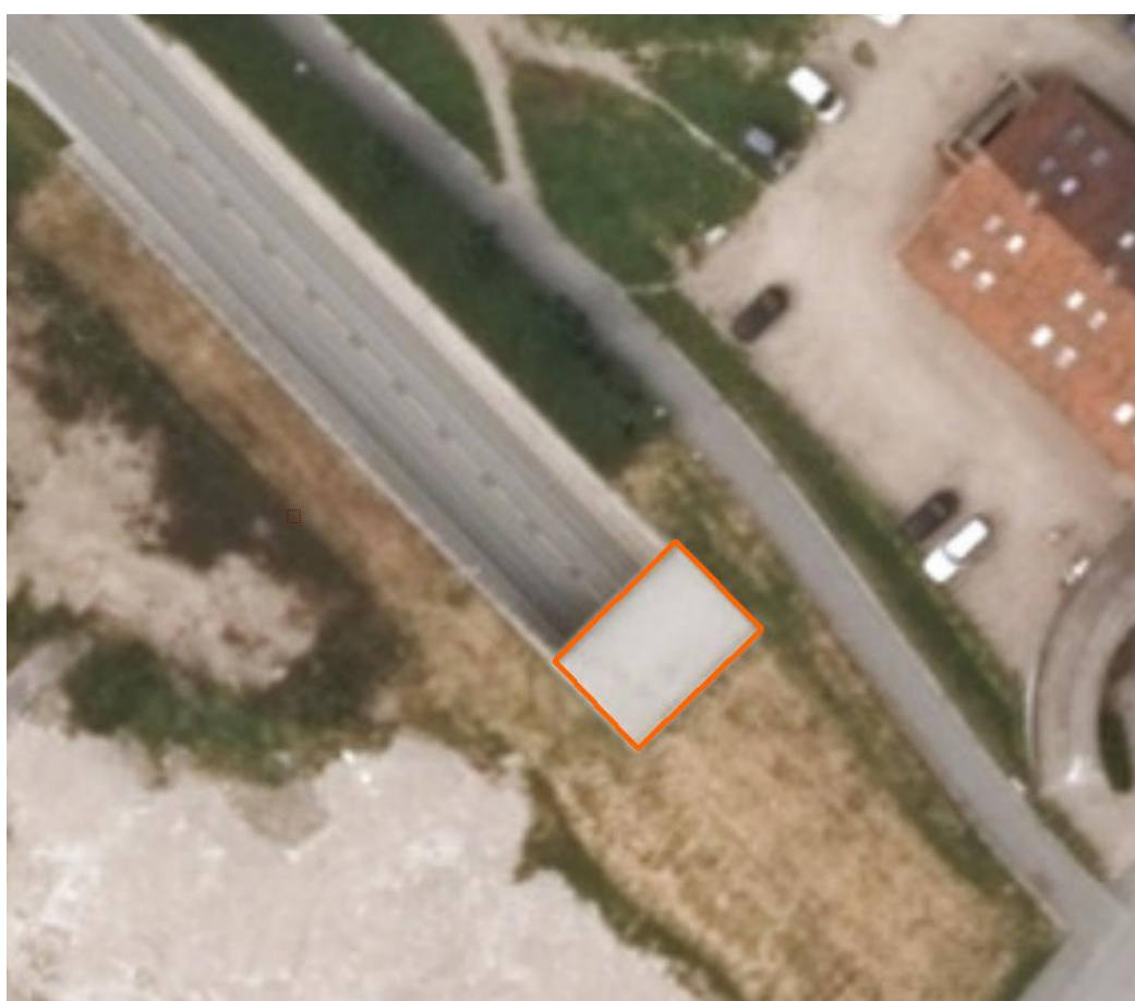
Figur 6: Eksempler på registrering av tunnelportal
